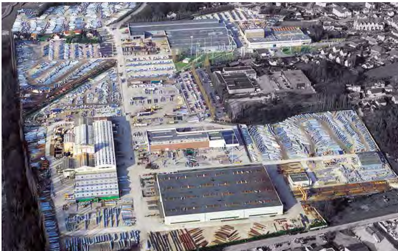
Vue aérienne du site Petitjean de Saint-André-les-Vergers (Aube - France) Aerial view of the Petitjean's site Saint-André-les-Vergers (Aube - France)
