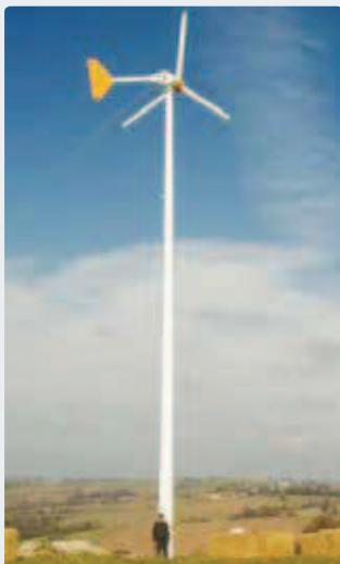
Supports pour éoliennes de 200 m<sup>2</sup> maximum de surface balayée intégrant les charges verticales d'un générateur, l'effort horizontal dû au vent, les forces vibratoires présentées par une structure de turbine.
